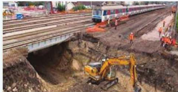
Ex : Elargissement d'un pont rail
