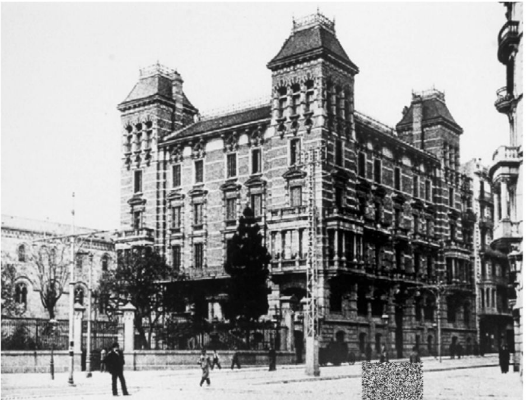
Building of the Compañía Central de Alumbrado por Gas, Lebon y Cía., 20 th century. Archive Naturgy.
